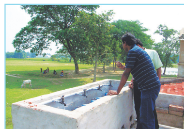
ブロックプリントの製品をつくっているインドの小さな生産者団体では、浄水設備を手作り。プリントによる排水をすべて浄水することが可能になりました。
